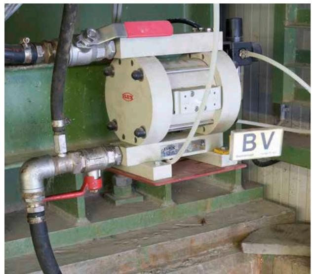
RFM：将中型散装容器 (IBC) 中的混凝土外加剂泵送至混合塔内。
