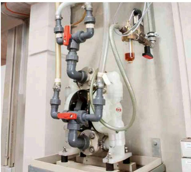
FDM：泵送电镀槽用化学镍料。
